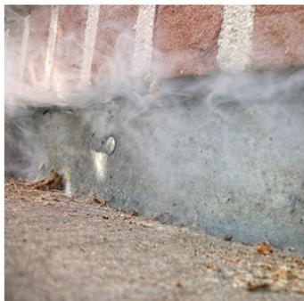
Признаки дефектной герметизации стенового соединения над подземным гаражом.
