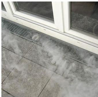
Неисправная герметизация террасы на крыше.
