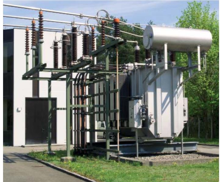
использование масла. Пример расходов: замена изоляционного масла в трансформаторе мощностью 80 кВА при стоимости масла 2,50 € и потребности ок. 15.000 л означает вложение ок. 37.500 €. Срок службы можно максимально увеличить путем точного определения качества масла и, следовательно, рентабельности.
